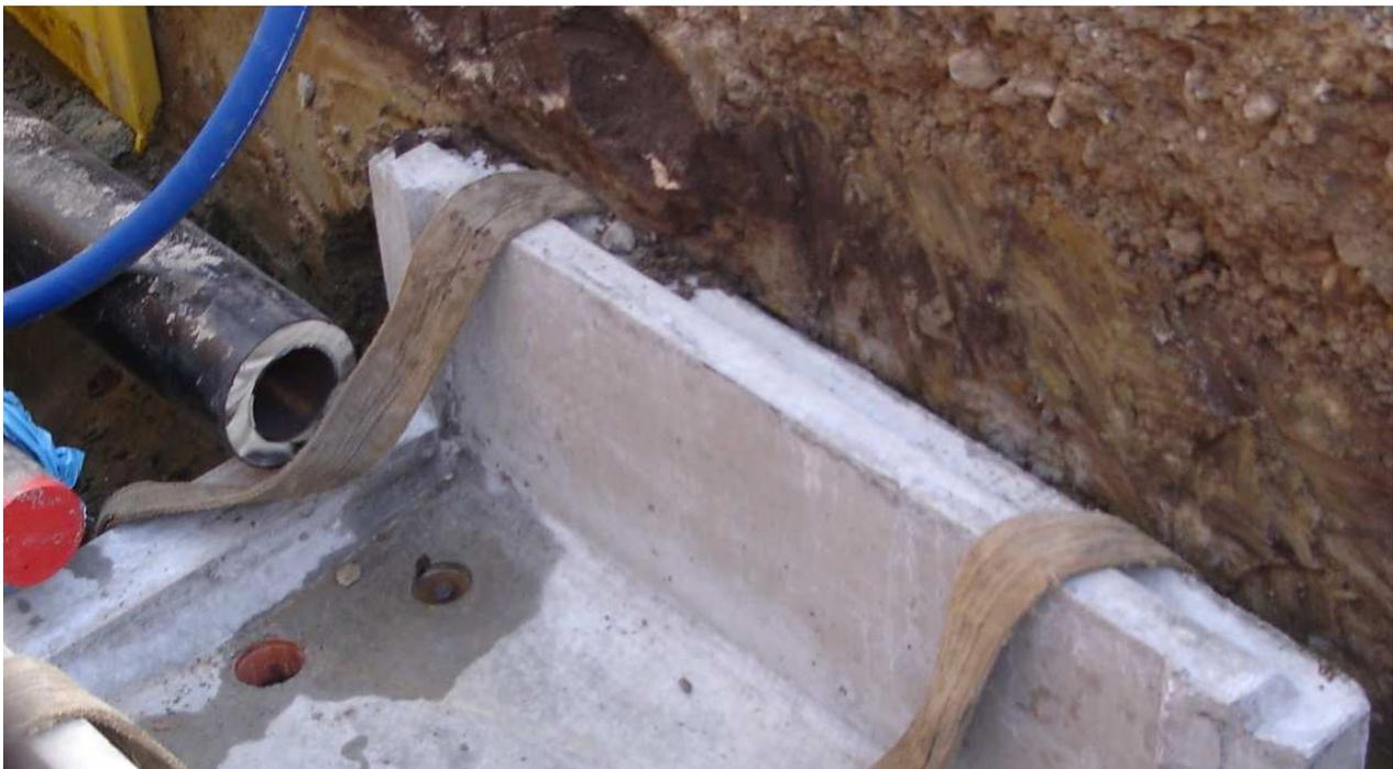
Bild 1— Fernwärme – Schachtunterteil
